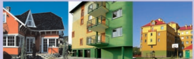
Elewacje wykonane w systemie Terranova
