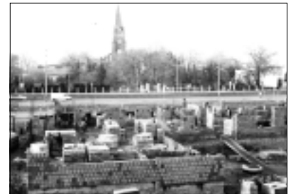
Trwa budowa komisariatu w Markach.
