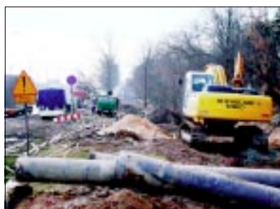
Budujemy kanalizację - str. 5
