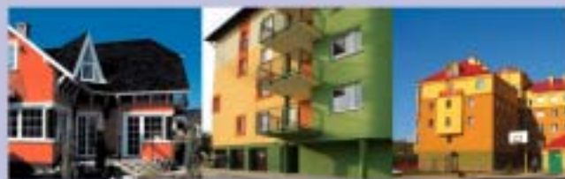
Elewacje wykonane w systemie Teranova
