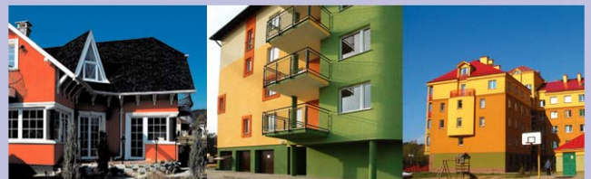
Elewacje wykonane w systemie Terranova
