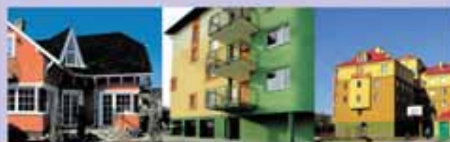
Elewacje wykonane w systemie Terranova
