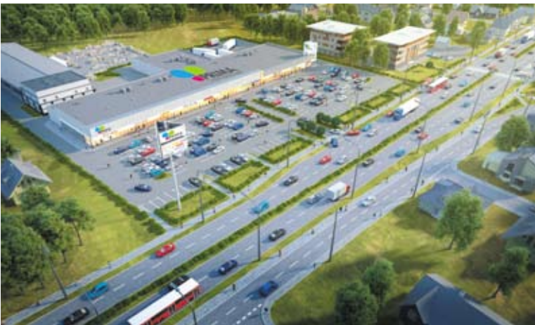
Centrum zlokalizowane jest przy Al. Piłsudskiego 200 (vis a vis ul. Dmowskiego). Planowana powierzchnia handlowa to 5300
