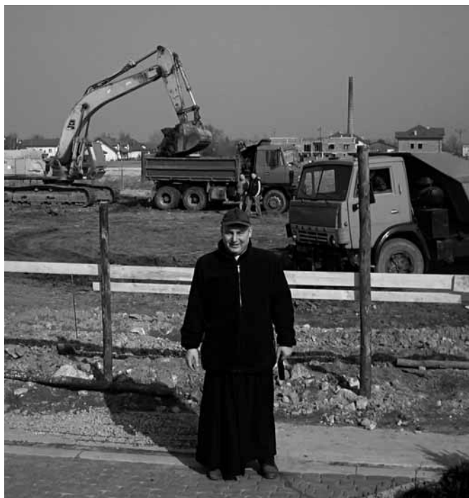
Ks. Proboszcz Dariusz Gugala na placu budowy kościoła. 10 III 2008.
