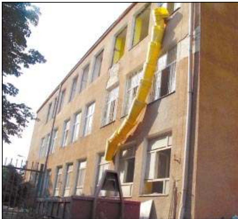
Remont SP nr 2 - widok od ul. Szkolnej.
