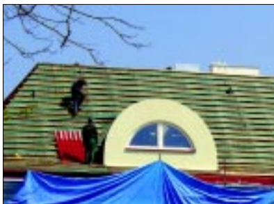
Prace przy rozbudowie Szkoły Podstawowej nr 3
